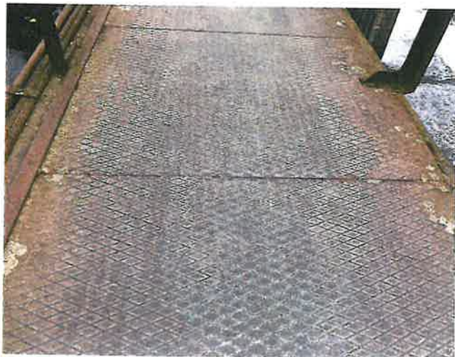
IMG_5442 - povrch mostovky je již bez funkční PKO
