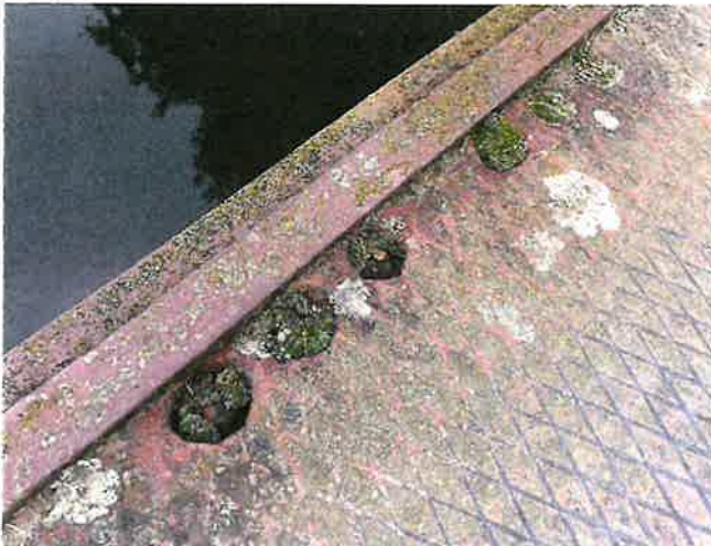
IMG_5452 - kotvení mostovky je napadeno korozi
