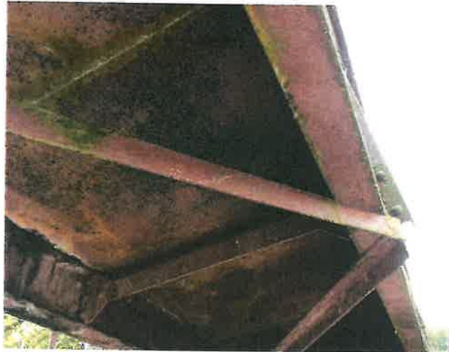
IMG_5556 - PKO mostovky je dožilá, plošně se vyskytuje povrchová koroze
