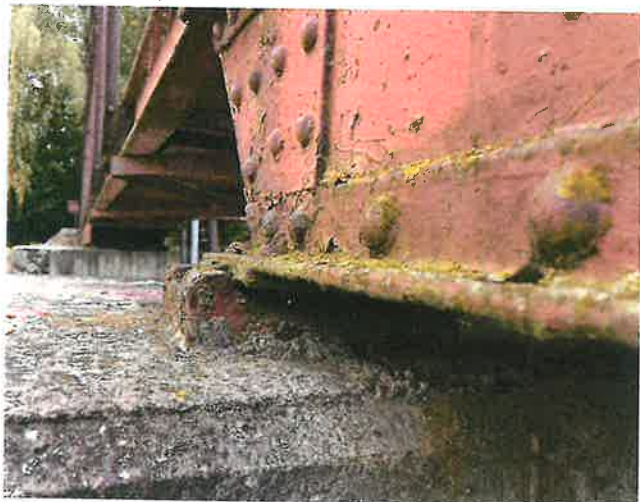
IMG_5495 - PKO nosné konstrukce je již dožilá, lokálně se vyskytuje prozatím spíše povrchová koroze
