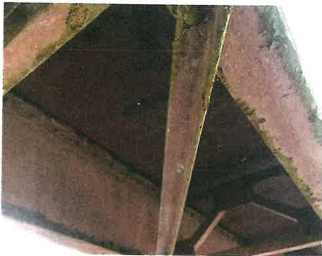
IMG_5548 - PKO ztužení nosné konstrukce je již dožilá, lokálně se vyskytuje prozatím spíše povrchov
