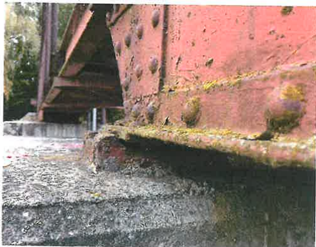
IMG_5497 - PKO nosné konstrukce je již dožilá, lokálně se vyskytuje prozatím spíše povrchová koroze
