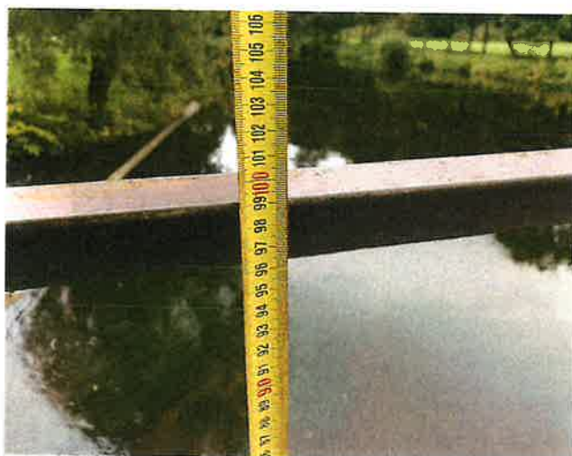
IMG_5460 - Výška zábradlí je cca 1000mm, nesplňuje současné normové požadavky
