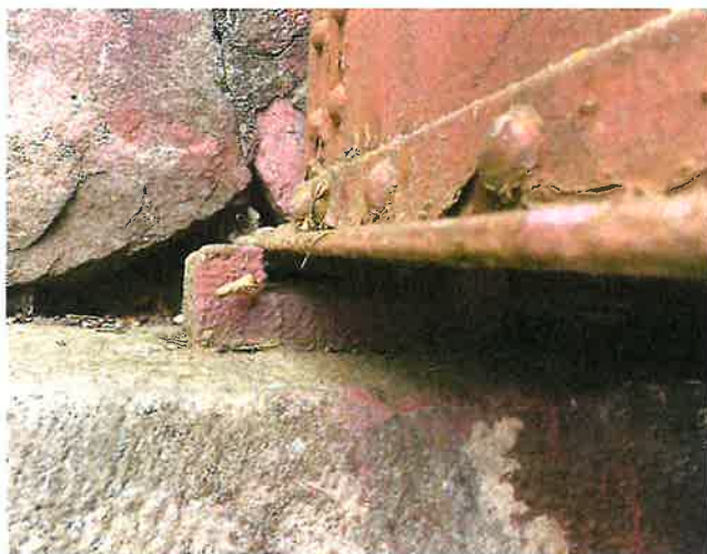
IMG_5505 - PKO nosné konstrukce je již dožilá, lokálně se vyskytuje prozatím spíše povrchová koruze
