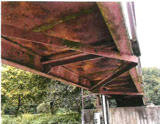
IMG_5529 - PKO mostovky je dožilá, plošně se vyskytuje povrchová koroze
