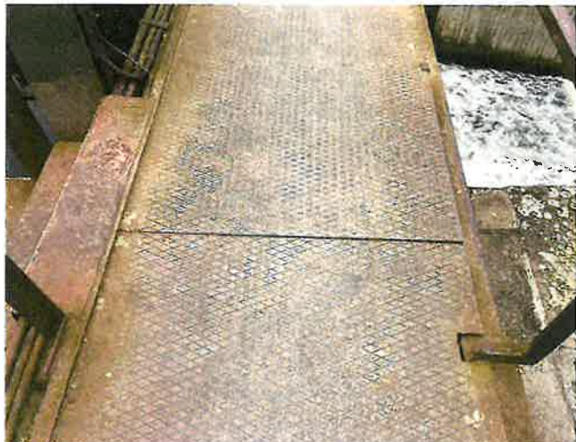
IMG_5444 - na vstupu na pole 2 je odrezlé kotvení mostkovkového plechu, výškový rozdíl max cca 10mm
