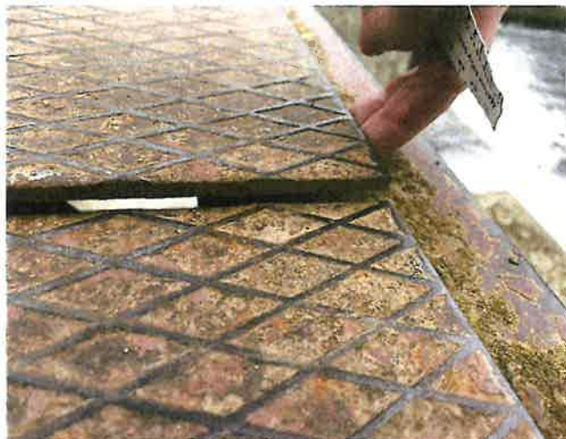
IMG_5445 - na vstupu na pole 2 je odrezlé kotvení mostkovkového plechu, výškový rozdíl max cca 10mm
