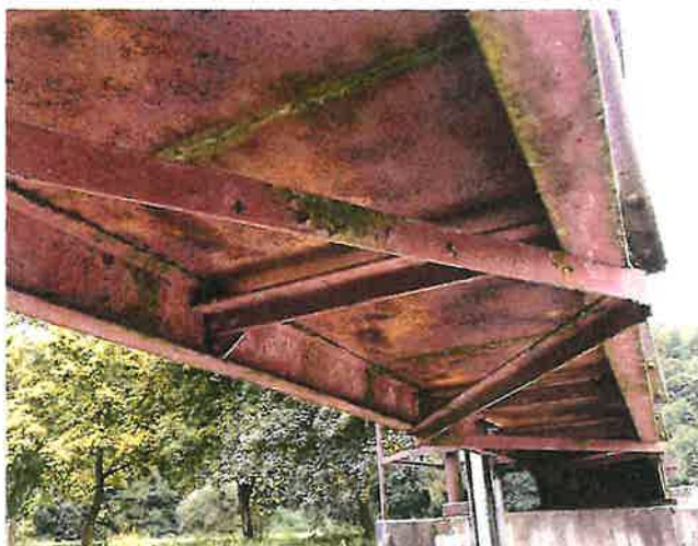
IMG_5528 - PKO ztužení nosné konstrukce je již dožilá, lokálně se vyskytuje prozatím spíše povrchov
