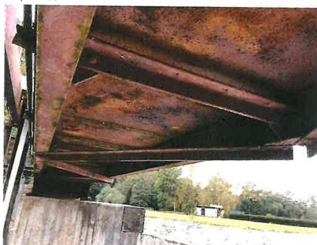
IMG_5522 - PKO mostovky je dožilá, plošně se vyskytuje povrchová koroze
