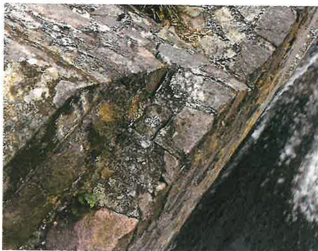
IMG_5566 - Zdivo opěry O4 má lokálně porušené spárování
