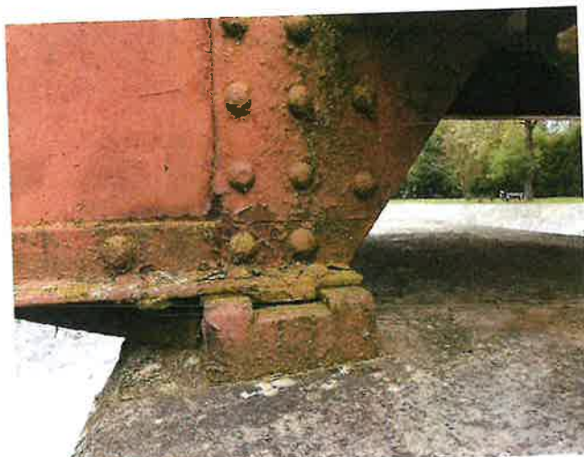
c_levé ložisko na pilíři P3
