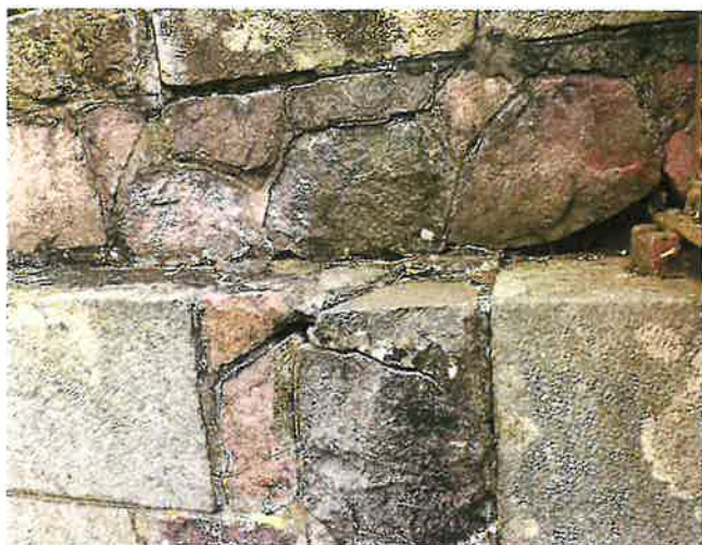
IMG_5502- Zdivo opěry O4 má lokálně porušené spárování
