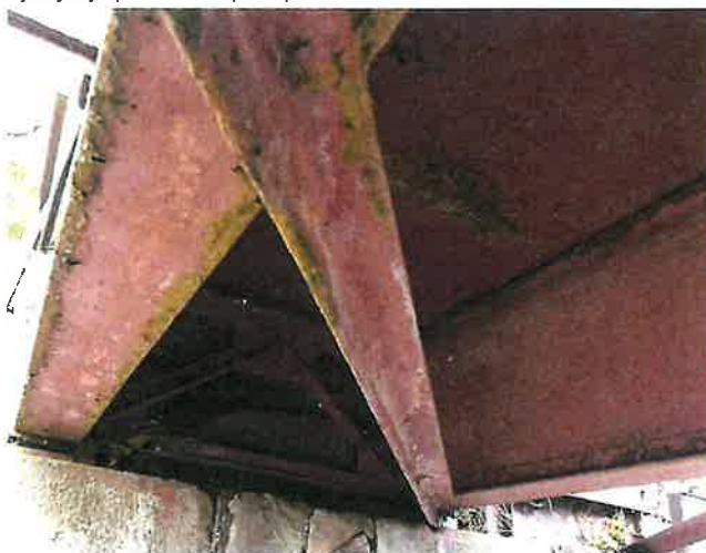
IMG_5547 - PKO ztužení nosné konstrukce je již dožilá, lokálně se vyskytuje prozatím spíše povrchov
