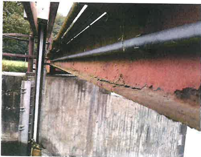
IMG_5523 - PKO nosné konstrukce je již dožilá, lokálně se vyskytuje prozatím spíše povrchová koroze
