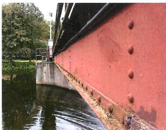
IMG_5510 - Nosná konstrukce je bez viditelných deformací
