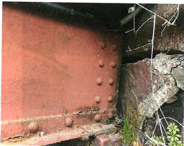
IMG_5512 - Závěná zídka opěry O4 má lokálně vypadlé výplně spár, rozpadá se
