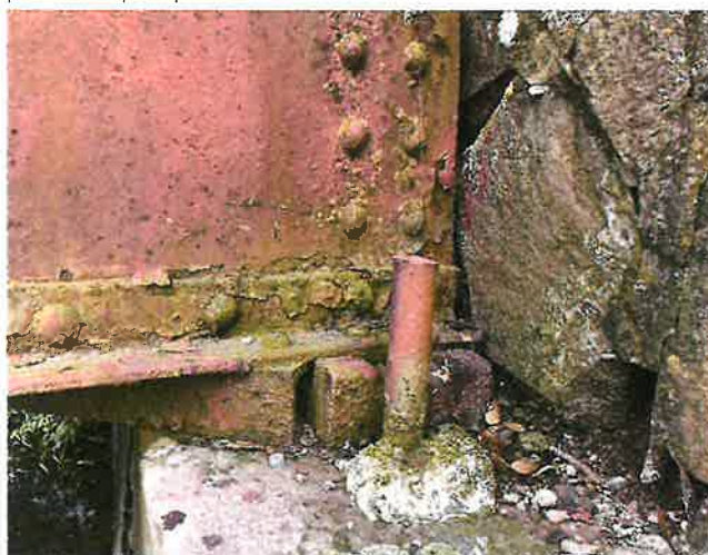
IMG_5508 - Závěsná zídka opěry O4 má lokálně vypadlé výplně spár, rozpadá se
