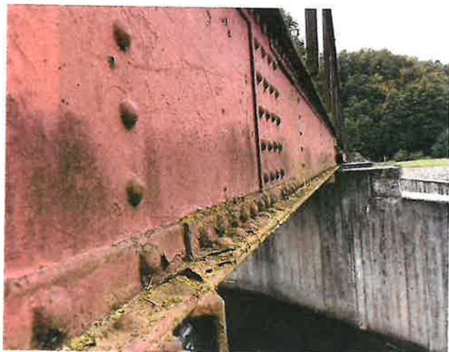
IMG_5518 - PKO nosné konstrukce je již dožilá, lokálně se vyskytuje prozatím spíše povrchová koroze
