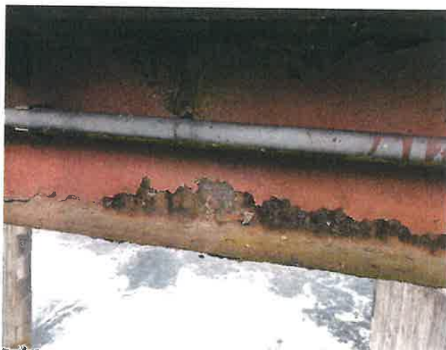
IMG_5524 - PKO nosné konstrukce je již dožilá, lokálně se vyskytuje prozatím spíše povrchová koroze
