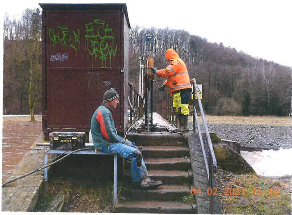
Obr. 6: Realizace vrtu V1 PB.
