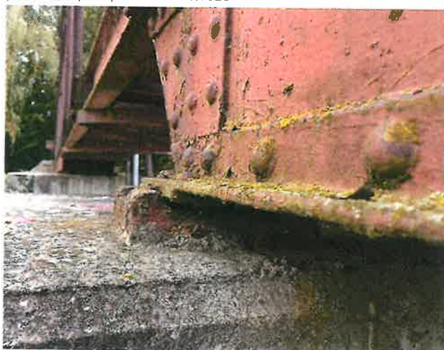
IMG_5496 - PKO nosné konstrukce je již dožilá, lokálně se vyskytuje prozatím spíše povrchová koroze
