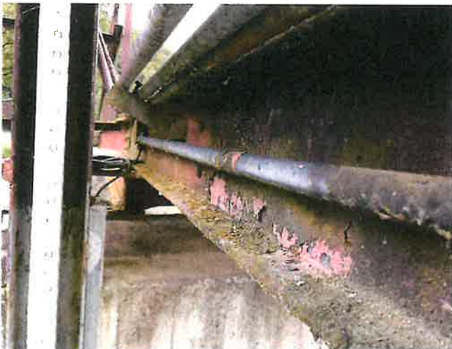
IMG_5531 - PKO nosníku regulace stavidla je drobně porušená, lokální koroze
