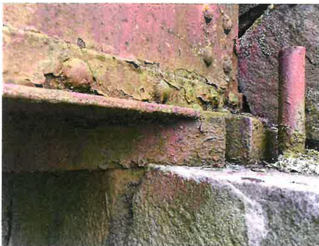
IMG_5509 - PKO nosné konstrukce je již dožilá, lokálně se vyskytuje prozatím spíše povrchová koruze
