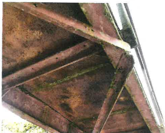
IMG_5554 - PKO mostovky je dožilá, plošně se vyskytuje povrchová koroze
