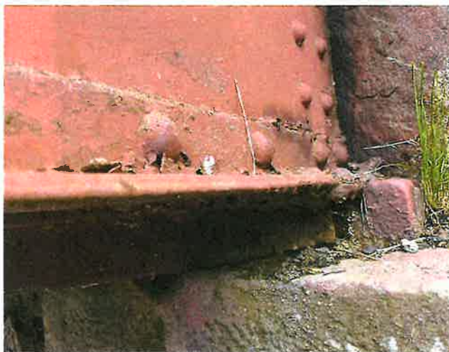
IMG_5479 - PKO nosné konstrukce je již dožilá, lokálně se vyskytuje prozatím spíše povrchová koroze
