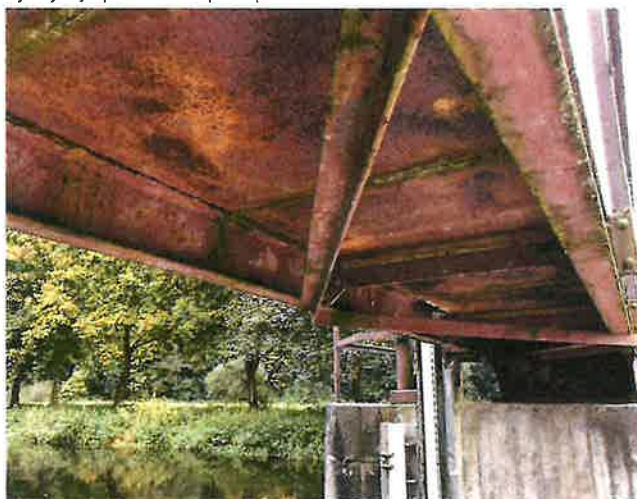
IMG_5530 - PKO ztužení nosné konstrukce je již dožilá, lokálně se vyskytuje prozatím spíše povrchová
