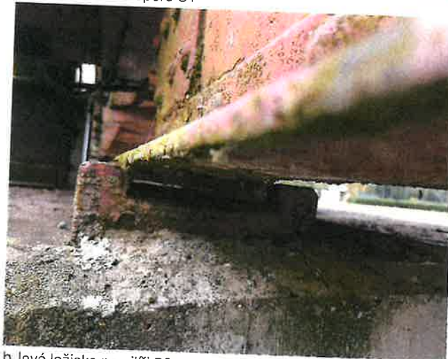
b_levé ložisko na pilíři P2
