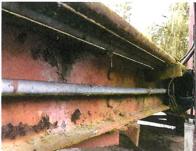
IMG_5525 - PKO nosné konstrukce je již dožilá, lokálně se vyskytuje prozatím spíše povrchová koroze
