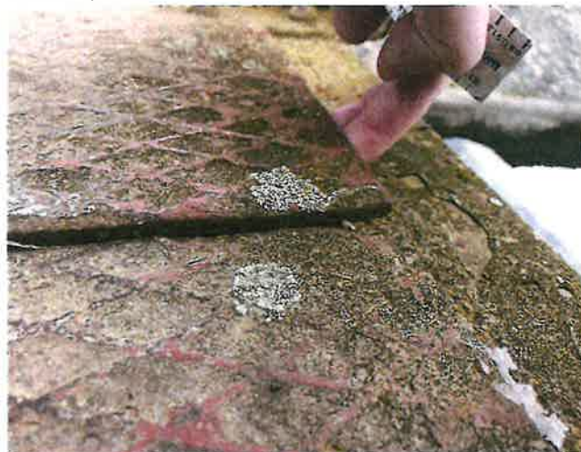
IMG_5451 - na vstupu na pole 3 je odrezlé kotvení mostkovkového plechu, výškový rozdíl max cca 10mm
