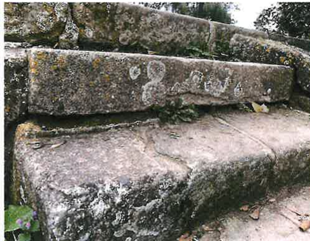
IMG_5456 - drobný propad schodišťového stupně na konci lávky
