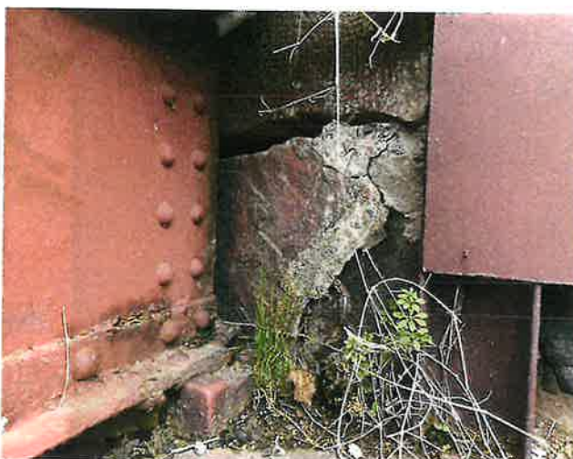
IMG_5513 - Závěná zídka opěry O4 má lokálně vypadlé výplně spár, rozpadá se
