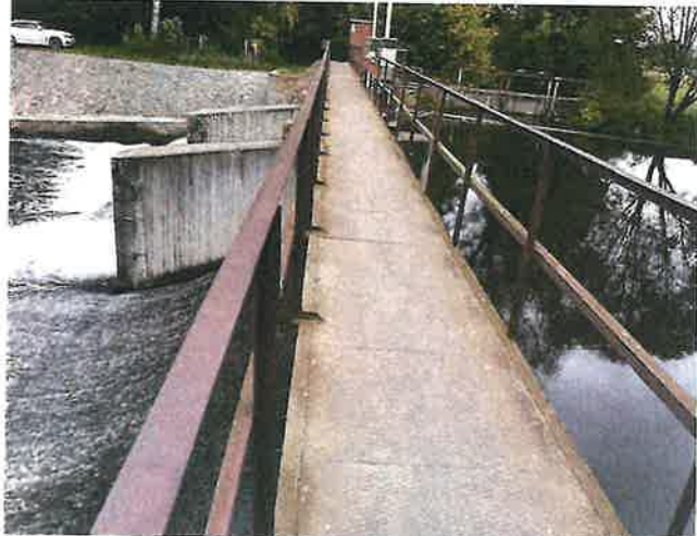
IMG_5472 - PKO zábradlí je dožilá, plošně se vyskytuje povrchová koroze
