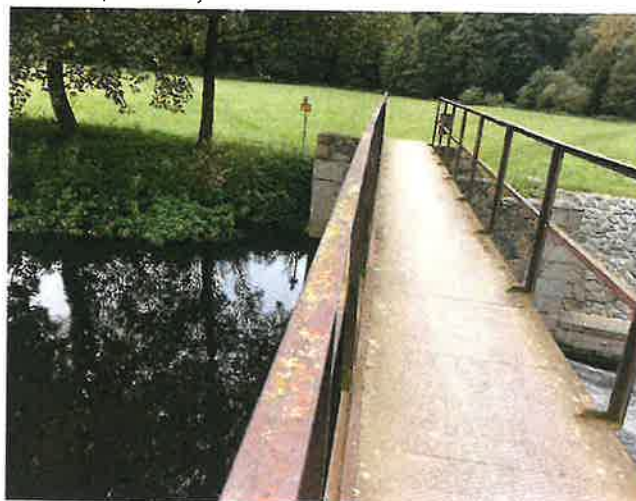
IMG_5468 - levé zábradlí pole 3 je mírně deformované
