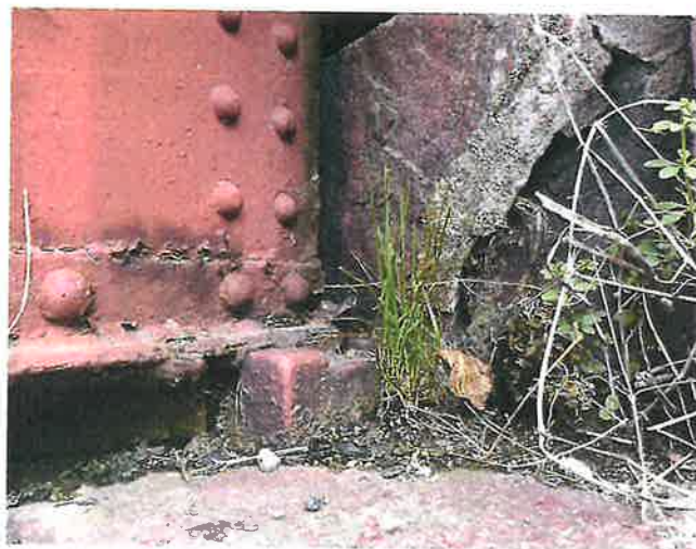
IMG_5477 - Na úložném prahu opěry O1 jsou nečistoty
