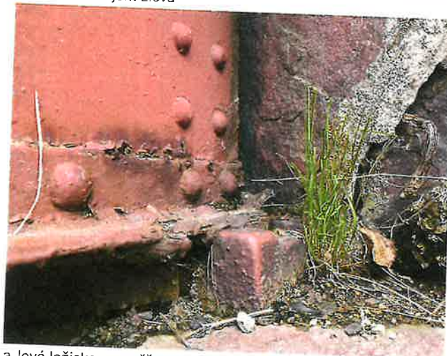
a_levé ložisko na opěře O1
