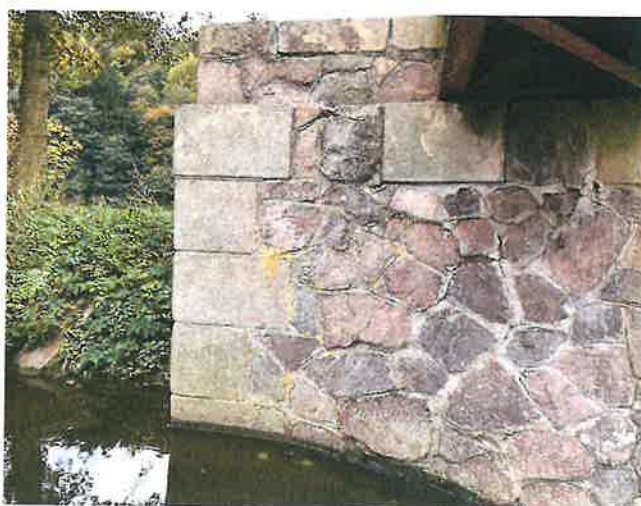
IMG_5500 - Zdivo opěry O4 má lokálně porušené spárování
