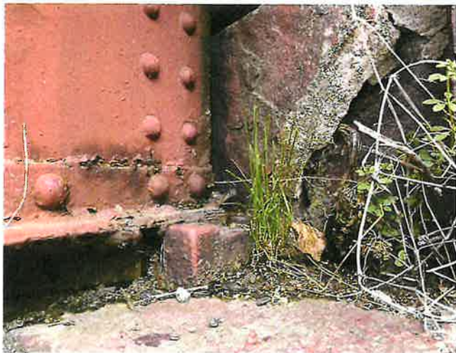
IMG_5478 - Závěrná zídka opěry O1 má lokálně vypadlé výplně spár a rozpadá se
