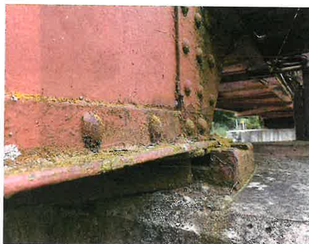
IMG_5493 - PKO nosné konstrukce je již dožilá, lokálně se vyskytuje prozatím spíše povrchová koroze
