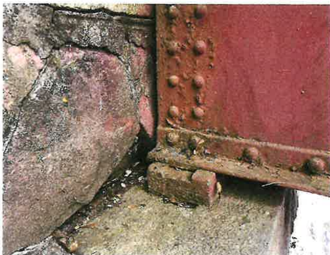
IMG_5506 - PKO nosné konstrukce je již dožilá, lokálně se vyskytuje prozatím spíše povrchová koruze
