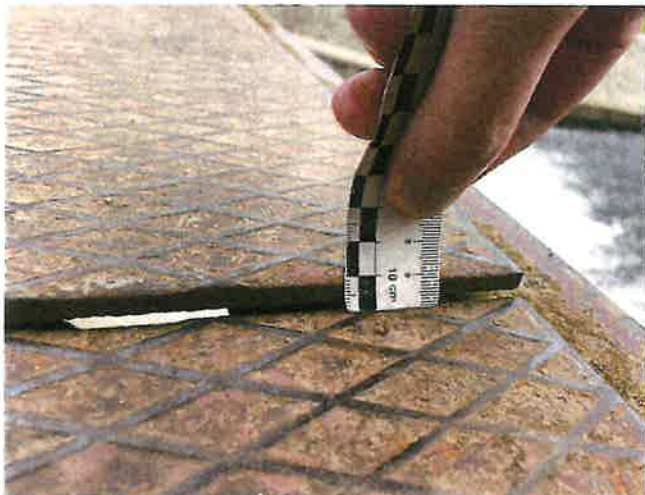
IMG_5446 - na vstupu na pole 2 je odrezlé kotvení mostkovkového plechu, výškový rozdíl max cca 10mm
