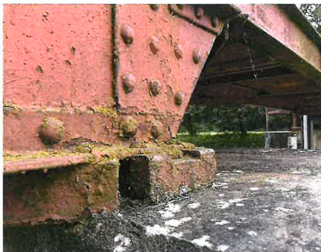
IMG_5487 - PKO nosné konstrukce je již dožilá, lokálně se vyskytuje prozatím spíše povrchová koroze
