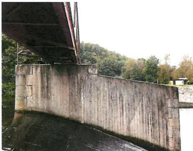
IMG_5483 - Na pilíři P2 z pole 1 vpravo je svislá trhlinka do 0,5mm, zdá se neaktivní
