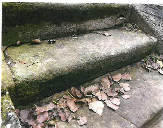
IMG_5437 - drobný propad schodišťového stupně na začátku lávky
