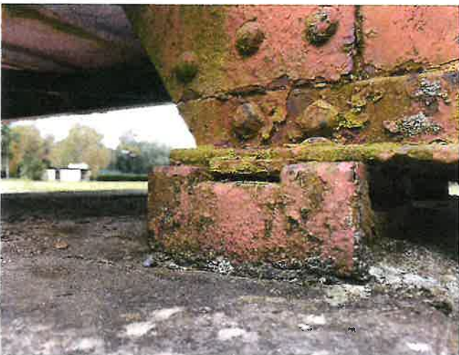
IMG_5484 - Ložiska mají dožilou PKO, vyskytuje se prozatím povrchová koroze
