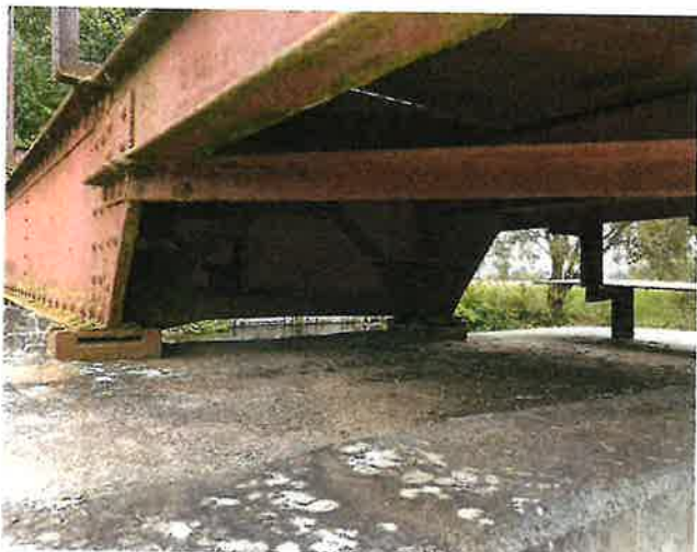
IMG_5488 - PKO nosné konstrukce je již dožilá, lokálně se vyskytuje prozatím spíše povrchová koroze
