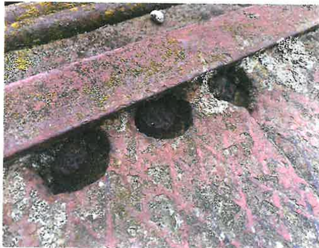
IMG_5443 - kotvení mostovky je napadeno korozi
