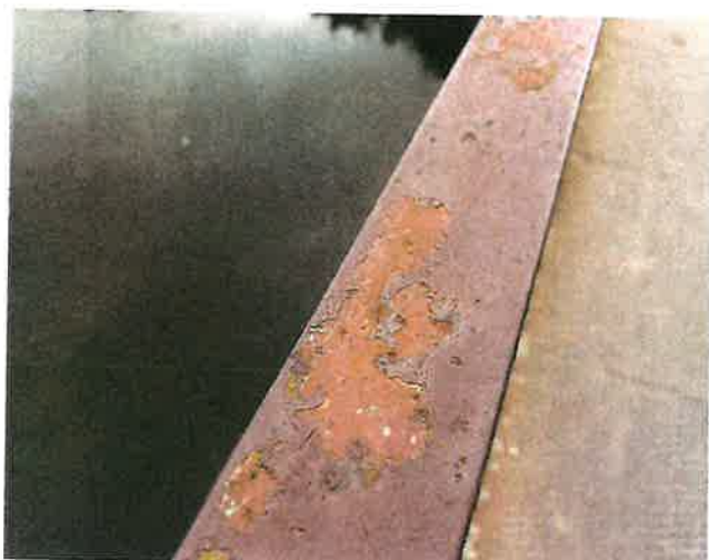
IMG_5459 - PKO zábradlí je dožilá, plošně se vyskytuje povrchová koroze
