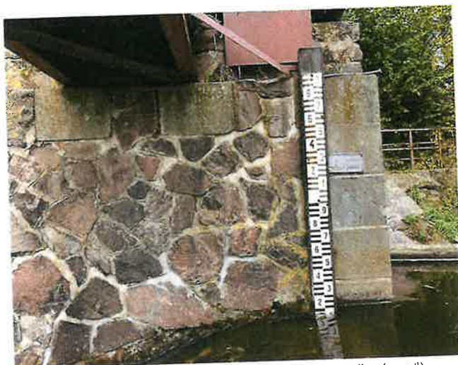
_Levé křídlo na začátku mostu (K1), (navazující opěrná zed')
